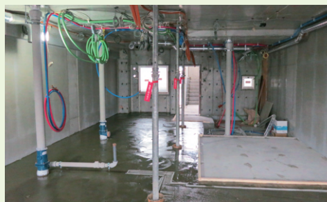
床レベリング工事
