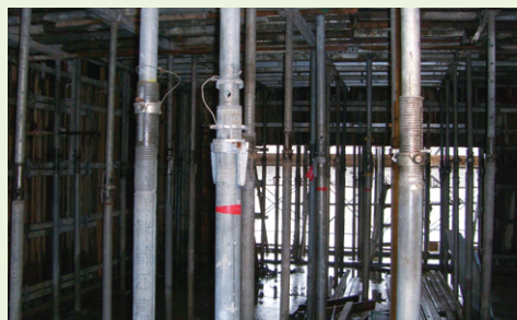
解体前（打設後約2日目）
