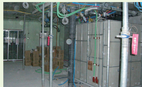
ユニット設置
