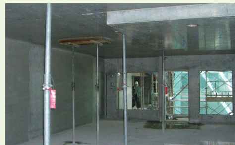
一般支保工解体後（打設後約4日以降）
