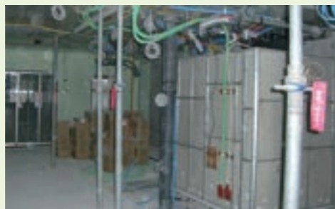
ユニット設置
