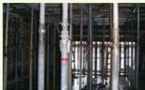
解体前（打設後約2日目）
