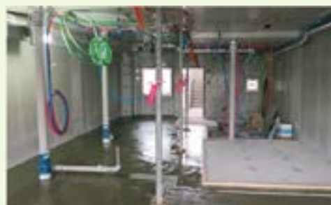
床レベリング工事
