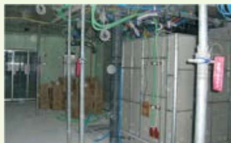
ユニット設置
